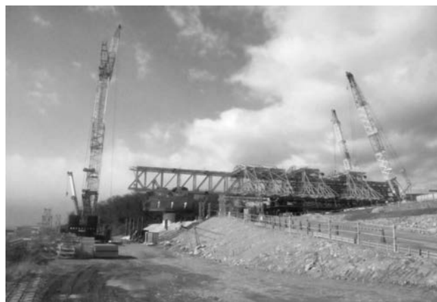
写真-2 架設桁・型枠装置 組立全景
