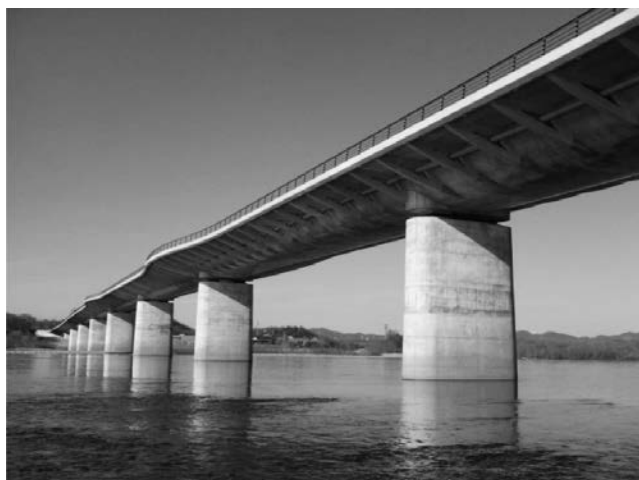
写真—7 完成全景
