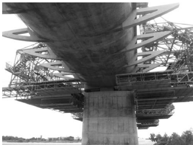
写真－5 下部フレーム スライド状況
