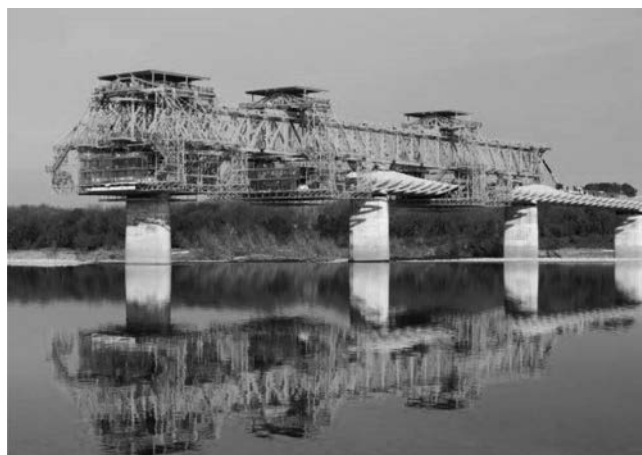
写真－3 移動架設桁を用いた張出し架設状況
