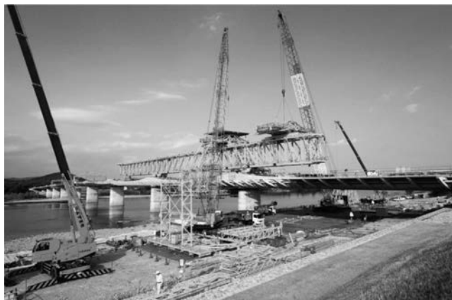
写真—6 架設桁・型枠装置 解体全景
