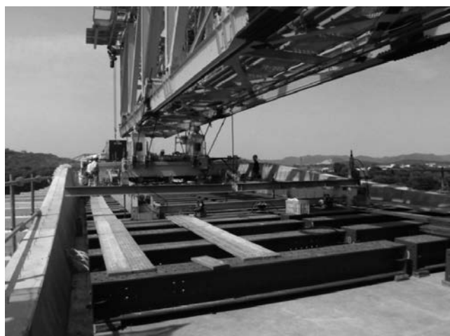
写真－4 荷重分散梁 設置状況
