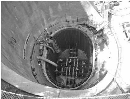
写真-1 小判形断面の大口径深礎
