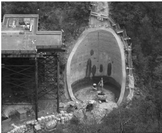
写真—2 竹割り型土留め工法
