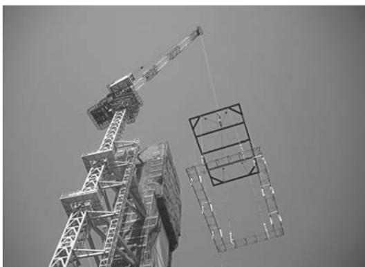
写真—6 鉄筋一括吊込み
