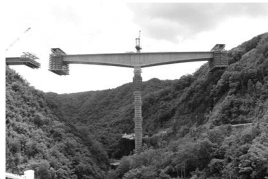
写真一12 P2橋脚からの張出し施工
