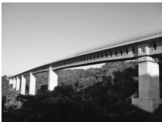
写真—8 完成写真
