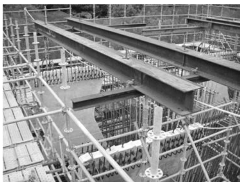
写真—4 柱頭部のバタフライウェブ架設状況
