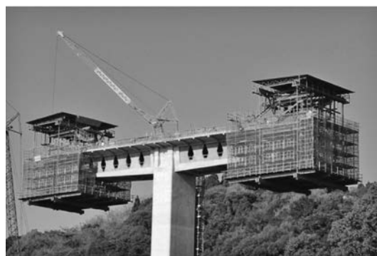
写真—5 張出し架設状況
