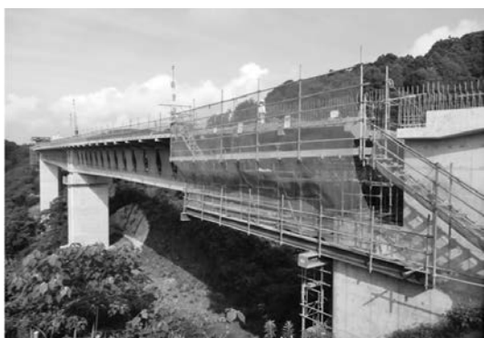
写真—7 A1 側径間部の施工状況
