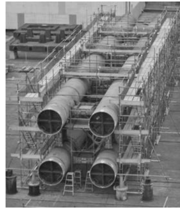
写真—2 仮組立状況
