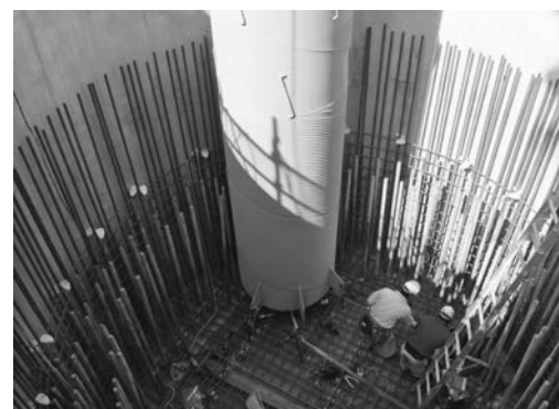
写真—4 基礎鋼管・基礎頂版の接合
