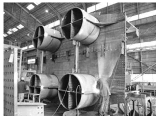
写真—3 剛結部 (鋼管と鋼桁下フランジの溶接)
