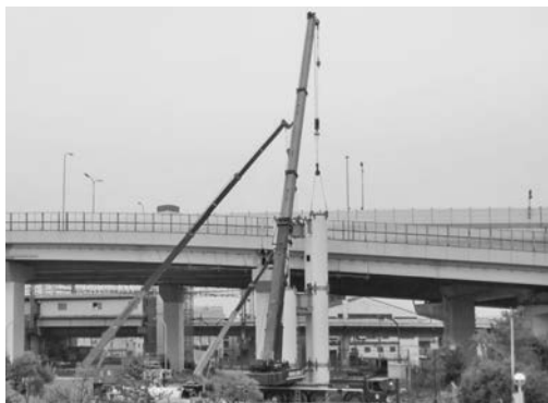
写真一5 柱部架設
