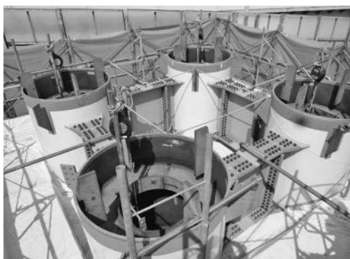
写真一6 横つなぎ材の接合
