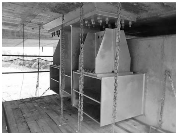
写真—7 完成状況
