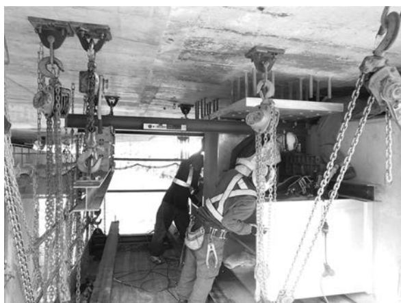
写真—6 ブラケット施工状況
