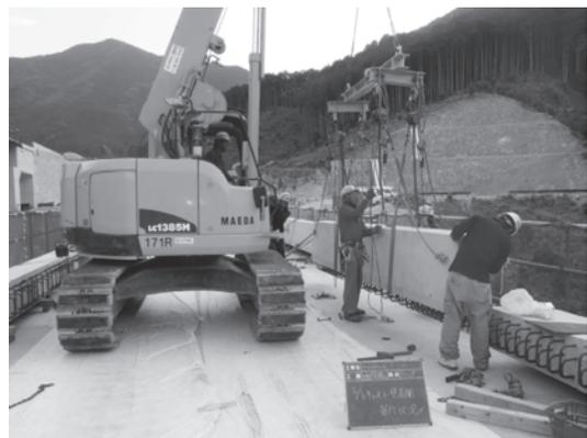
写真-5 プレキャスト部材据付け状況
