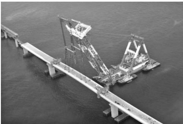
写真—11 中央径間の架設
