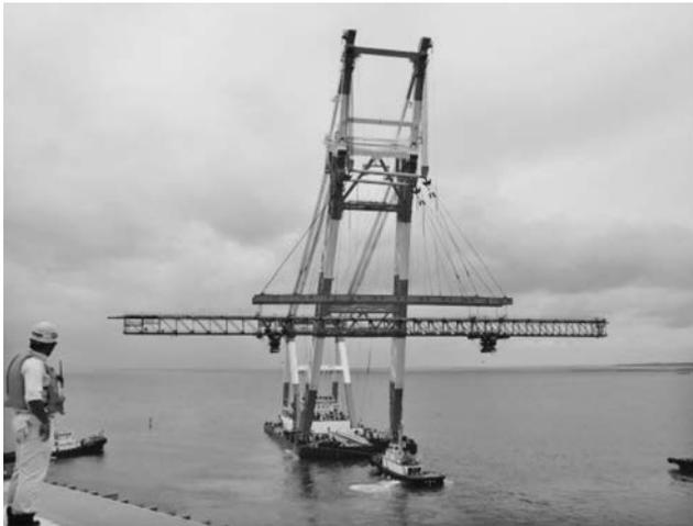
写真—10 PC部架設桁の移設
