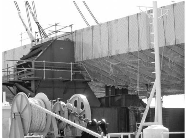
写真—7 横移動制限装置
