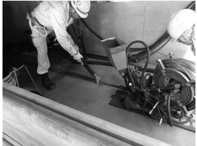
写真—12 風防設備内 継手溶接状況
