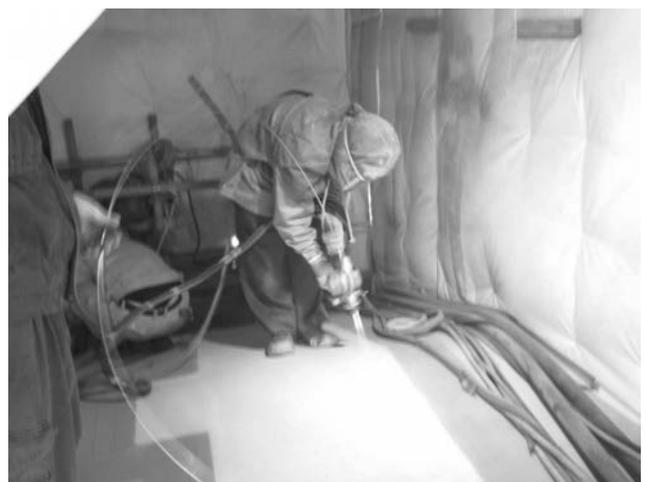
写真—13 風防設備内 Al-Mg 溶射状況
