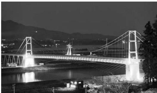
写真一八 ベルトコンベヤ用吊橋「希望のかけ橋」
