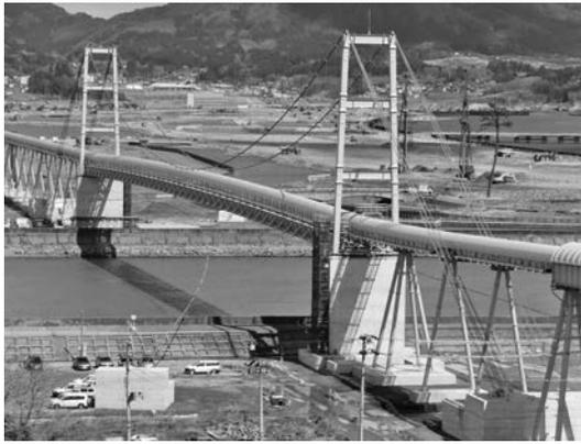
写真一六 ベルトコンベヤ用吊橋「希望のかけ橋」(土砂搬送中)
