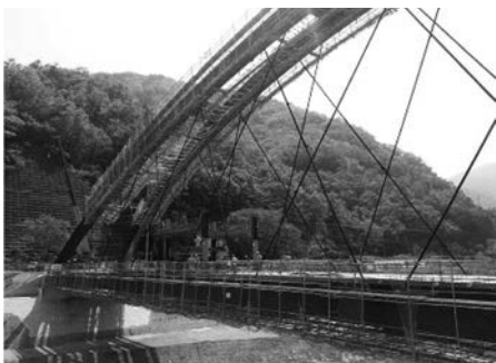
写真—1 施工中の PC 床版架設機①
