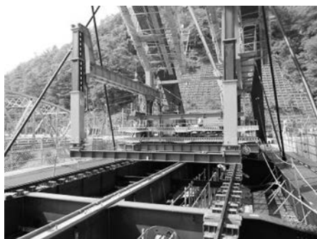
写真—3 施工中の PC 床版架設機③
