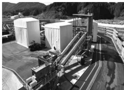
写真—14 造粒固化処理施設全景
