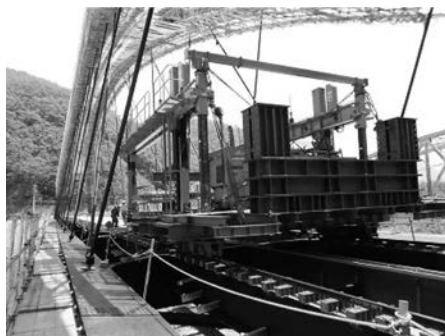
写真—4 施工中の PC 床版架設機④
