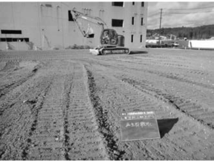
写真―23 駐車場路盤整備状況
