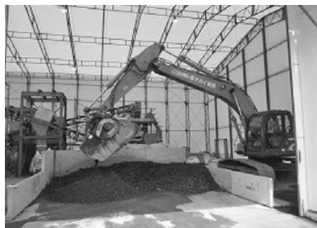
写真—8 焼却主灰破碎状況
