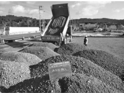
写真―22 造粒再生碎石搬入状況
