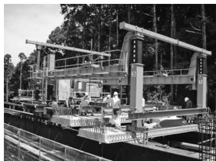
写真—6 PC 床版架設機（2号機）全景
