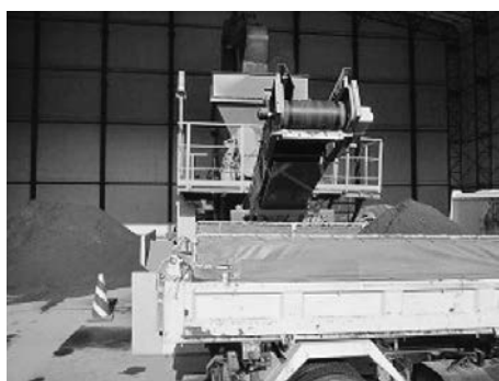
写真—12 混合原料排出
