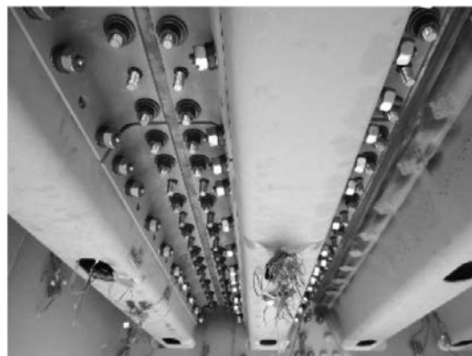
写真一 1 あて板の取付状況
