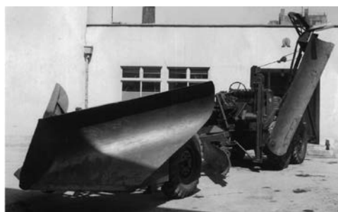
写真 4-9 3.7 m 級 100PS LG I スノーブラウ、サイドウイング付き 三菱日本重工業(株) (注4) 昭和 28 年
