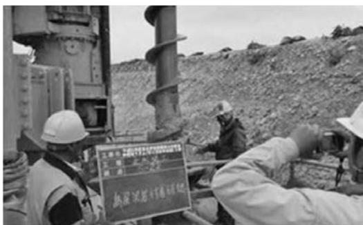
写真-2 不透水層土塊の付着確認状況
