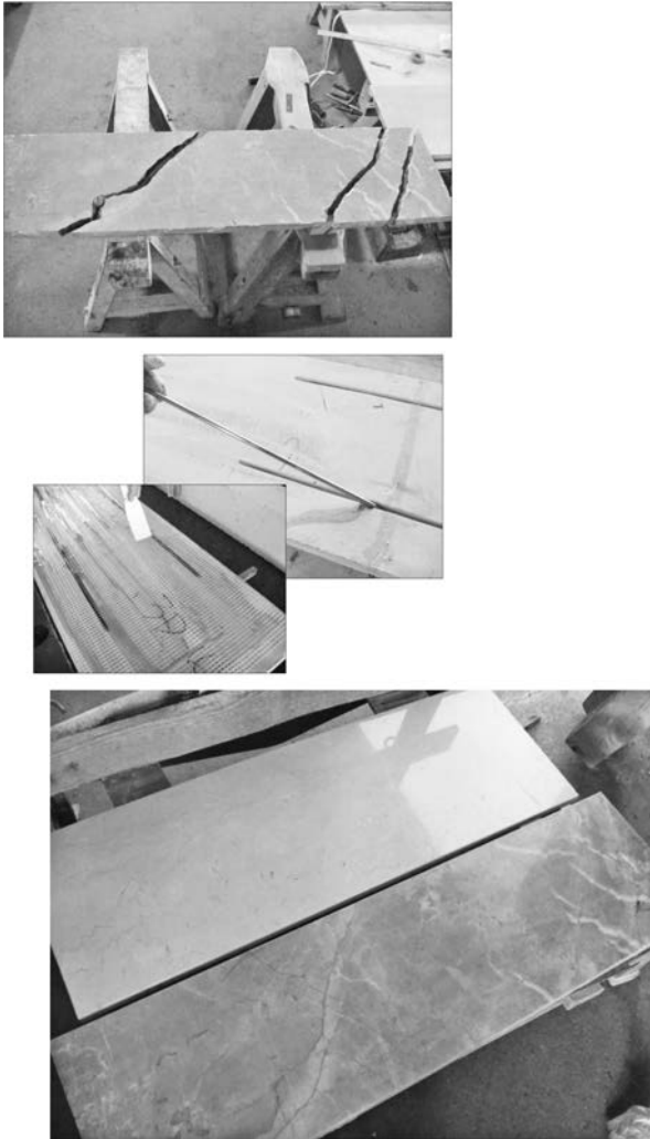
写真—9 解体し破損した石材は、復元加工し再利用
