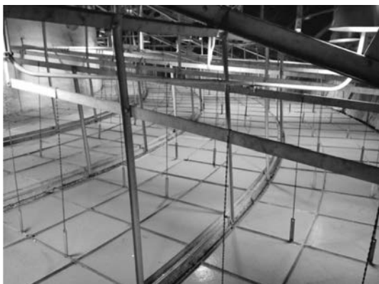
写真—3 既存天井下地の状況
