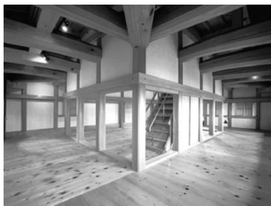
写真—2 天守1階内部
