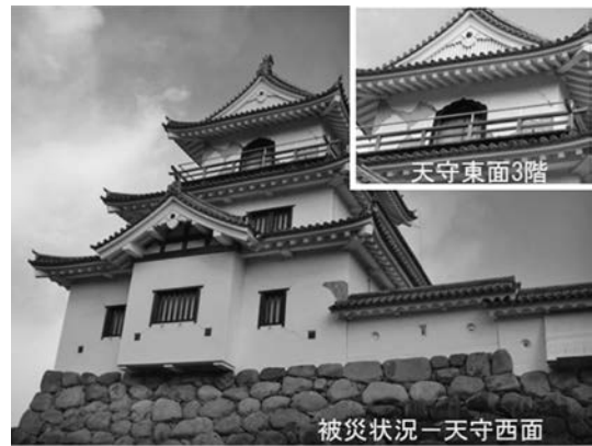
写真一4 3.11地震による被災状況
