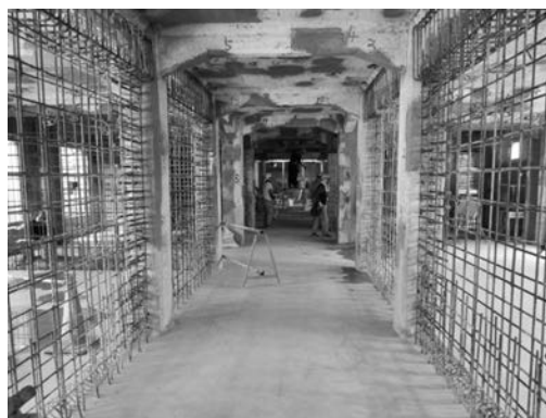
写真一5 耐震壁の増設
