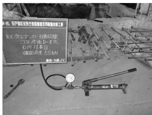
写真一6 あと施工アンカー引張試験
