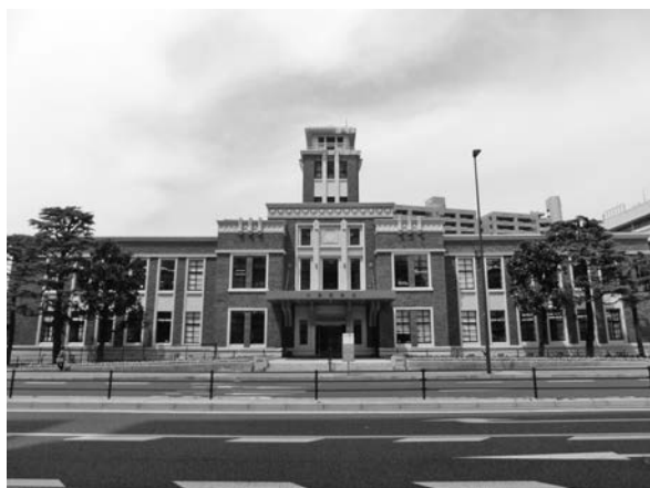
写真—1 建物外観（改修後）
