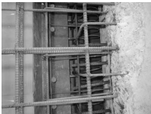
写真—11 接合部状況 2
