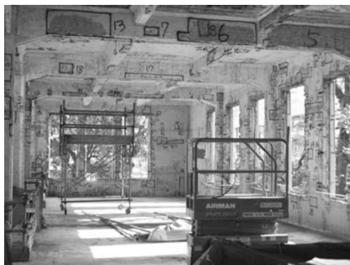
写真—14 既存躯体調査状況①
