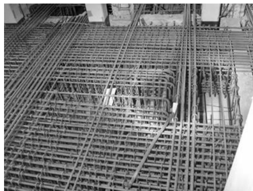
写真一4 基礎梁の補強
