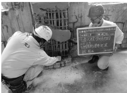
写真—17 防錆剤塗布
