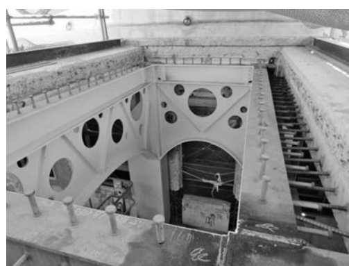
写真―10 接合部状況 1
