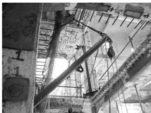
写真―8 塔屋下部鉄骨建方仮設ブーム
