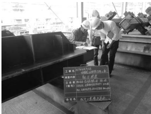
写真一3 アーチフレーム柱組立検査
