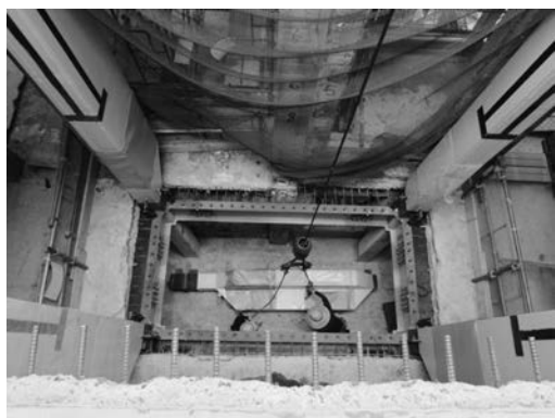
写真―7 鉄骨柱取り込み状況
