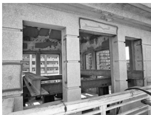
写真―9 塔屋鉄骨取り込み架台
