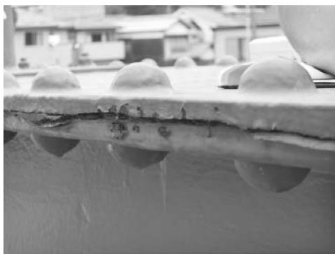
写真—4 現況のリベット
