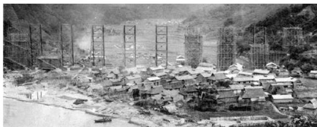
写真1 鋼トレススル式橋脚架設<sup>4)</sup>
