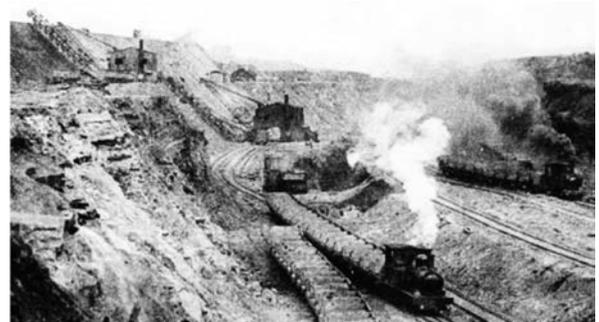
写真-6 山間部掘削のエクスカベータと土司機関車
