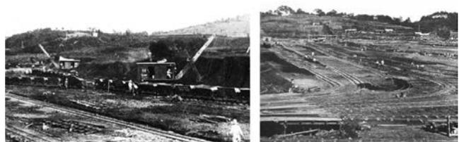
写真—16 山口調整池の土取場と堤体敷の線路網
