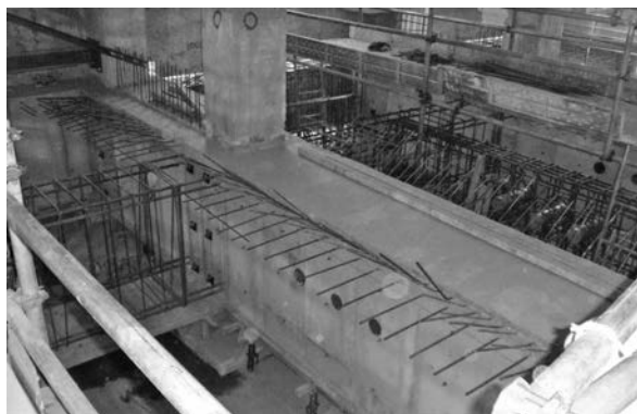
写真—5 新設地中梁の構築状況
