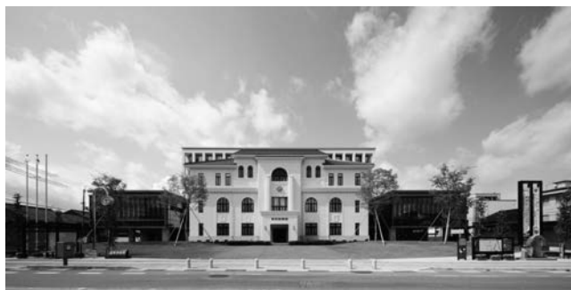
写真—3 完成写真
