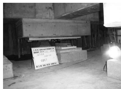
写真—14 グラウト注入の前後
