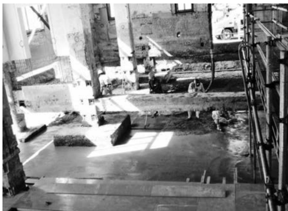
写真—4 建物内部の礎盤の構築
