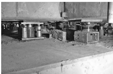
写真一 柱周りの状況
