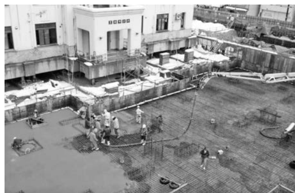
写真—6 移設先の耐圧版打設状況
