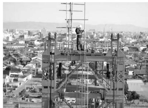
写真一七 電動ウインチ設置完了
