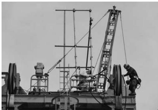
写真一九 ジンポールデリック設置完了
