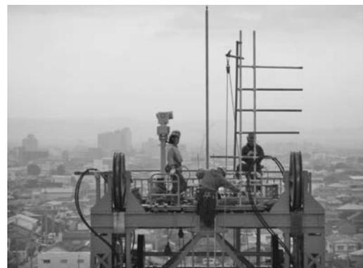
写真一六 電動ウインチ設置状況
