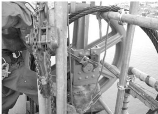
写真一十 可動桁滑車取り外し状況
