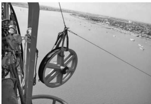
写真一十一 滑車を取り外し可動桁へ移動
