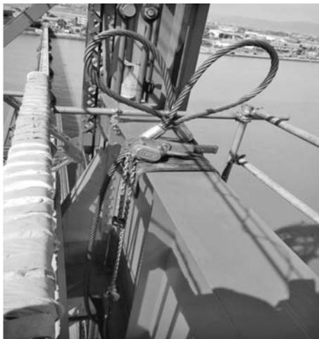
写真四 仮吊りワイヤー設置状況
