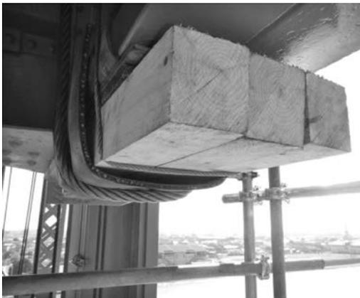
写真三 鉄骨部の養生状況
