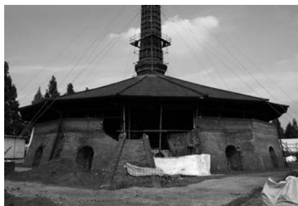
写真-1 修理工事前
