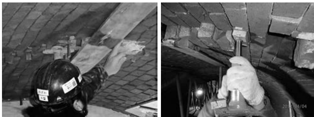
写真—25 煉瓦楔の打ち込み
