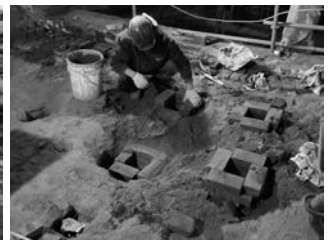
写真—29 投炭坑の修理
