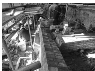
写真—12 外周壁仕上げ
