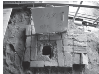
写真一 4 投炭坑口撤去前の状況
