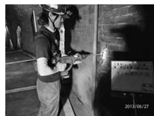
写真—32 電動ドリルで穿孔
