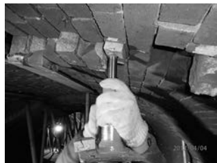
写真—26 油圧ジャッキによる押し上げ
