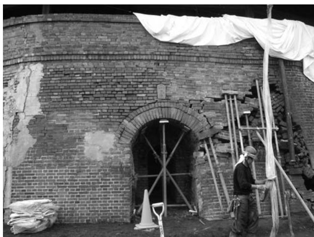
写真—9 外周壁修復
