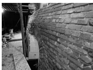
写真—10 アーチ上部の膨らみ
