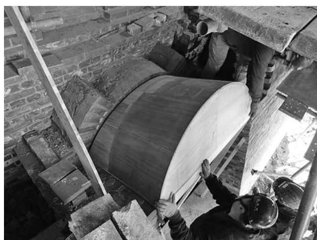
写真—14 アーチ芹杵の取り付け
