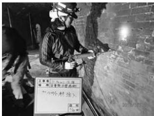
写真—33 グラウト材注入
