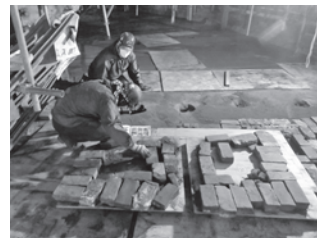
写真一 6 外部での煉瓦積み替え
