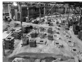
写真—30 投炭坑の煉瓦積み
