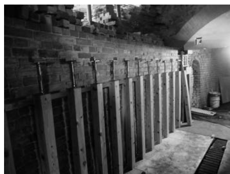
写真—15 350mm間隔の木柱
