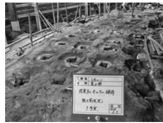
写真—28 施工前状況
