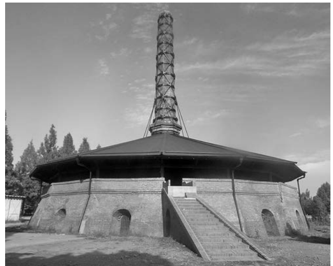
写真—36 修理工事後
