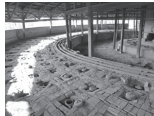
写真一 2 撤去前
