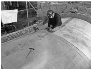
写真-19 段差の削り
