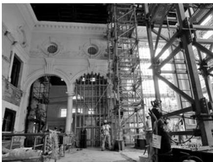
写真—17 アーチ開口部の補強状況
