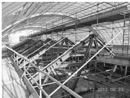
写真—15 新設屋根鉄骨施工中
