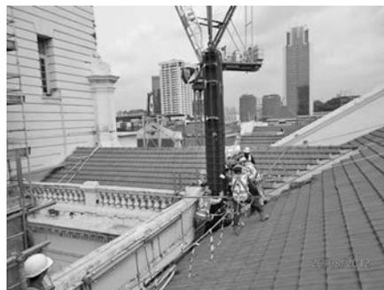
写真—21 鉄骨建方状況
