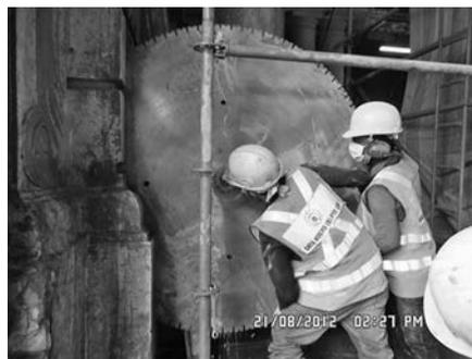
写真—18 丸ノコによる壁切断
