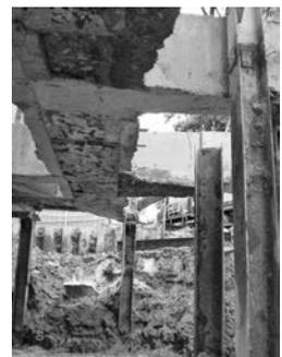
写真一10 掘削後、梁に支持された既存壁
