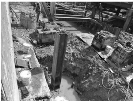
写真一2 H鋼柱(延伸後)
