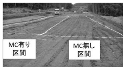
各区間：延長約 30 m × 幅約 6 m
