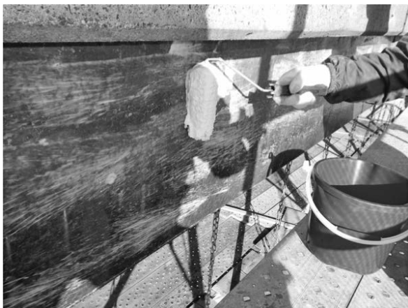
写真—8 主桁表面保護工（含浸系）
