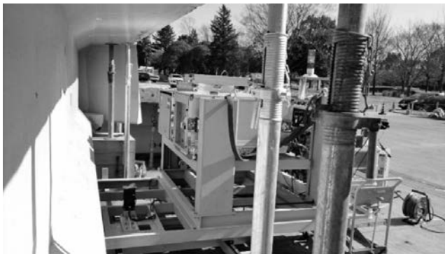
写真—2 PCT 桁橋の撮影
