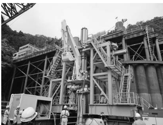
写真一6 水中作業機進水
