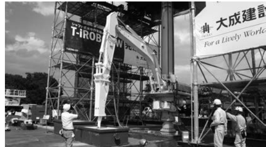
写真—2 コンクリート破碎状況
