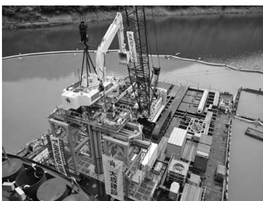
写真一5 水中作業機設置
