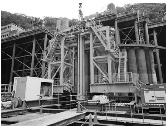
写真一4 シャフト組立
