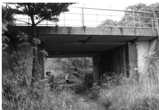
写真—6 検証試験で実施した新幹線橋梁
