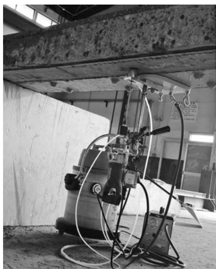
写真—10 下面からの削孔状況
