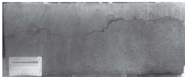
写真ー3 水平ひび割れを有する試験体
