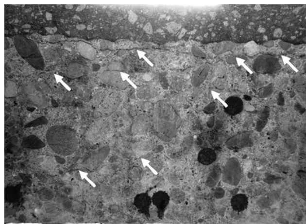
写真-8 微細ひび割れの状況
