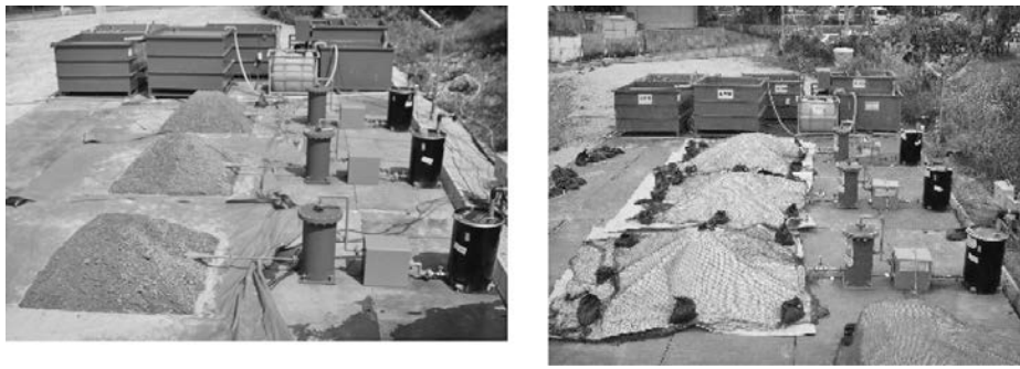
写真—1 バイオパイル写真（写真奥からパイルA, パイルB, パイルC）
