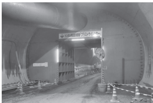
写真一1 音響管式消音器の設置状況
