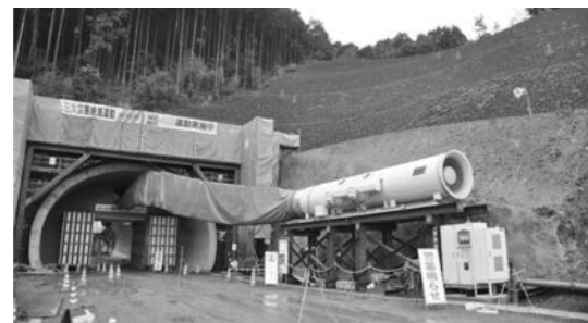
写真一七 坑口部の状況
