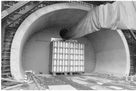
写真一八 消音システム設置状況
