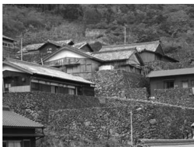
写真—1 外泊 石垣の里
