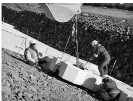
写真一 水平吊りによる玉掛け（荷卸し作業）：左、斜吊りによる玉掛け（据付け作業）：右
