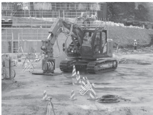
写真—4 法面締固機
