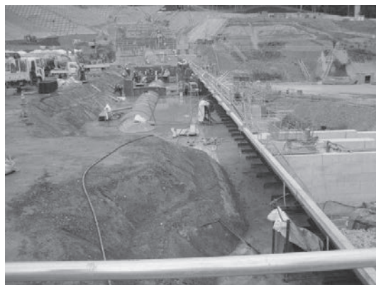
写真—5 CSGとコンクリートの境界法面
