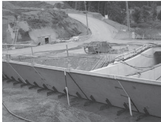
写真—7 プレキャスト型枠
