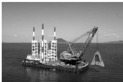
写真12 大旺新洋 第十五龍正丸 グラブ浚渫船兼起重機船
