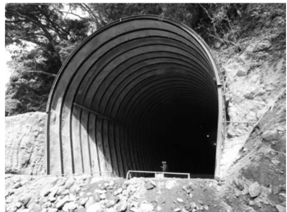
写真一 3 工事状況（転流工吐き口）
