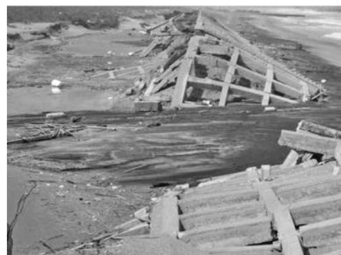
写真—1 浸食により破壊に至った堤防
