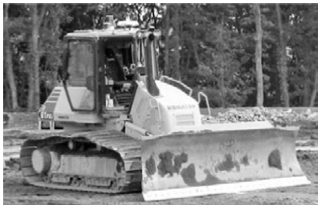
写真-3 ブルドーザ
