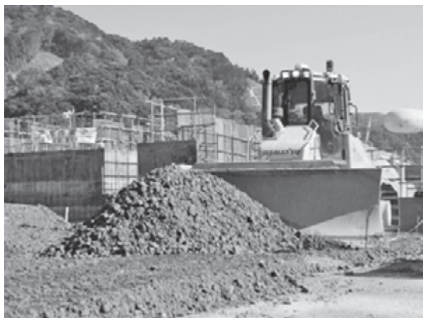
写真—4 RCD ダム工事での自動運転状況
