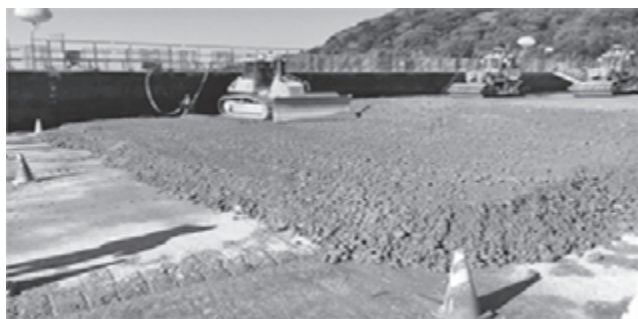
写真—5 RCD コンクリート自動まき出し・整形状況
