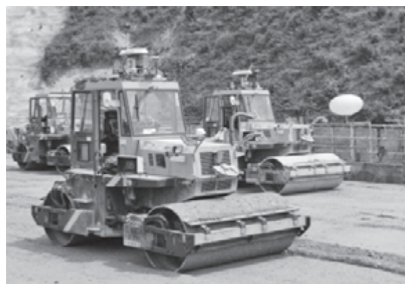
写真—2 2台同時施工の状況
