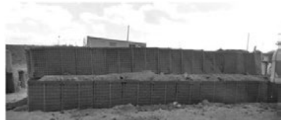
写真-3 実証実験での出来形状況
