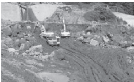
写真—4 軟弱地盤下での施工状況
