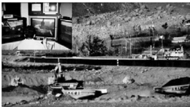
写真—1 雲仙普賢岳 試験フィールド施工状況
