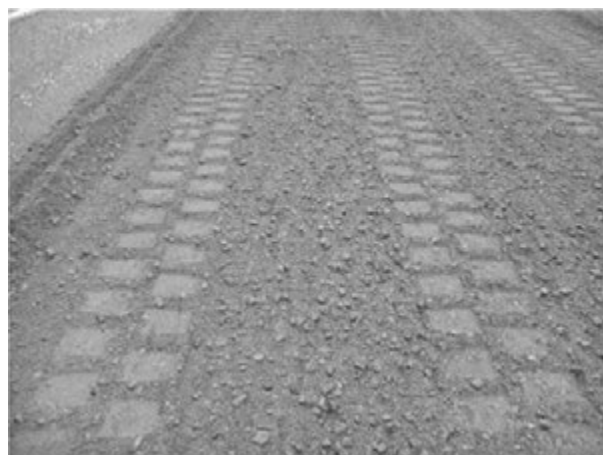
写真—9 敷きならし面におけるCTLのクローラ跡
