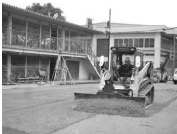
写真—7 施工状況（2DMC）
