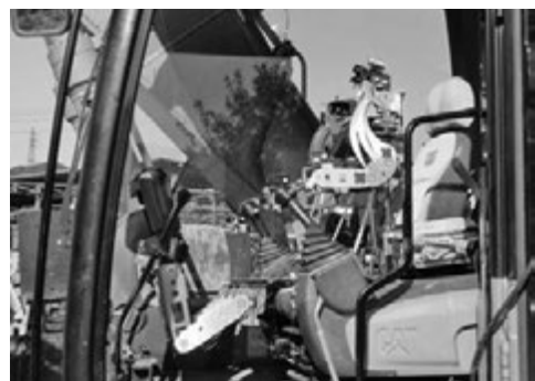
写真—8 設置完了状況
