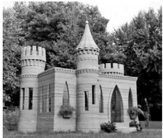
図—12 米国ミネソタ州のアンドレー・ルーデンコ氏が巨大3Dプリンターで造った住宅サイズのお城（写真・資料：Andrey Rudenko）
