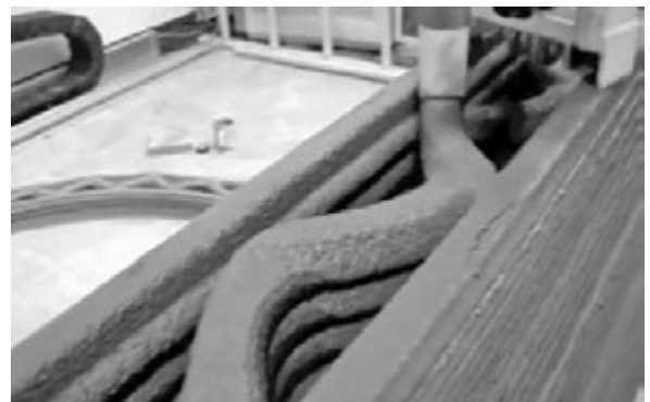
図—11 巨大3Dプリンター「コンター・クラフティング」の完成イメージ（上）。壁の造形風景（下）。壁の内側、外側、内部を順次、層状に積み重ねて造っていく（資料・写真：南カリフォルニア大学）
