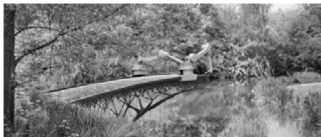
図—15 3D プリンターで鋼橋を架ける現場のイメージ (資料：MX3D B.V.)
