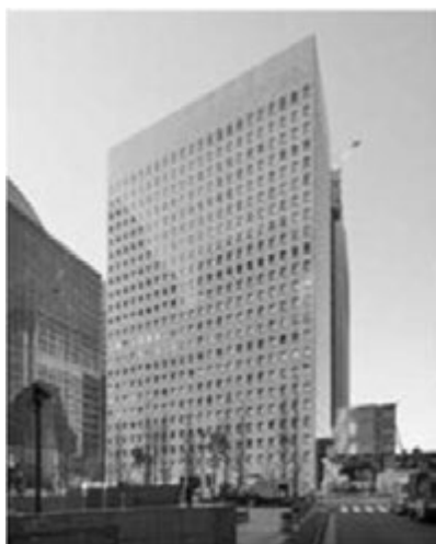
写真—1 大手センタービル
