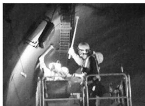
写真一3 打音検査の作業状況
