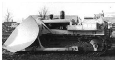
写真 5-2 履带式ドーザ NTK-7 (Vプラウ)
