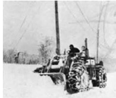
写真 5-9 除雪ドーザ Cat950 キャタピラージャパン(株) 昭和42年
