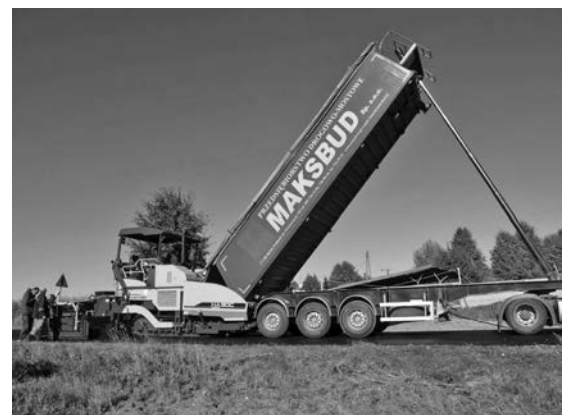
写真一 三 ポーランドでの稼働例
