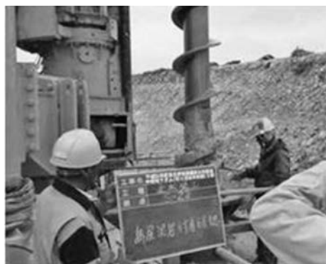
写真一1 不透水層土塊の付着確認状況
