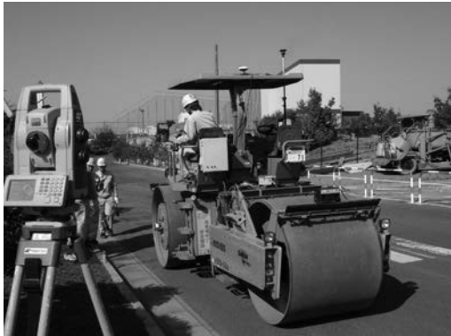
写真-9 試験状況写真
