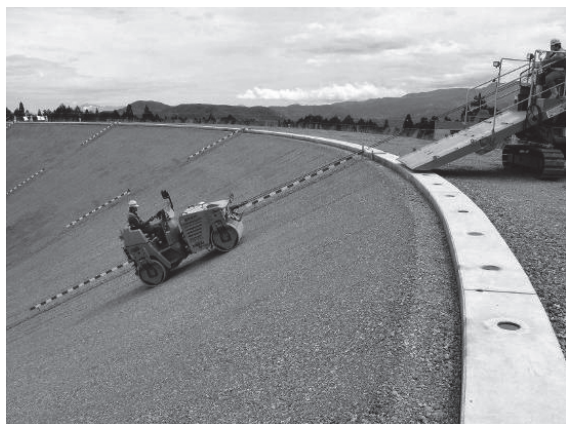
写真一4 ダム・ため池舗装工事例
