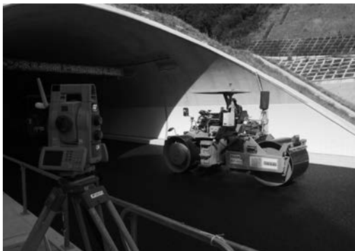
写真-10 坑口付近施工状況
