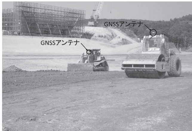
写真—1 敷均し転圧状況
