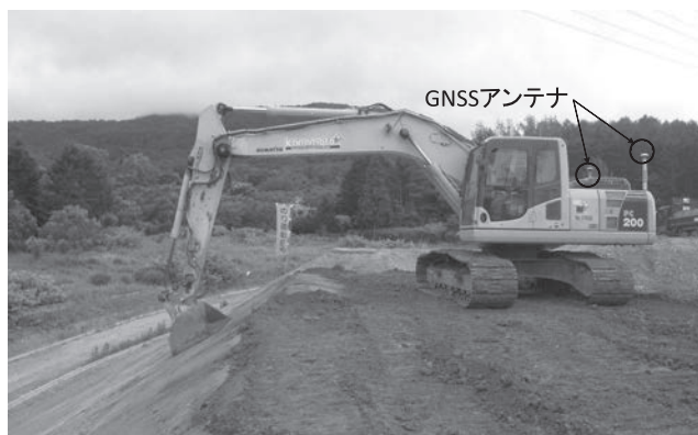
写真—2 法面締固め状況
