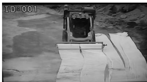
写真—8 養生作業状況
