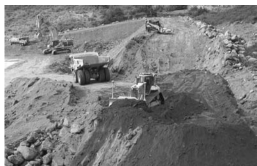
写真—7 カメラ車利用状況
