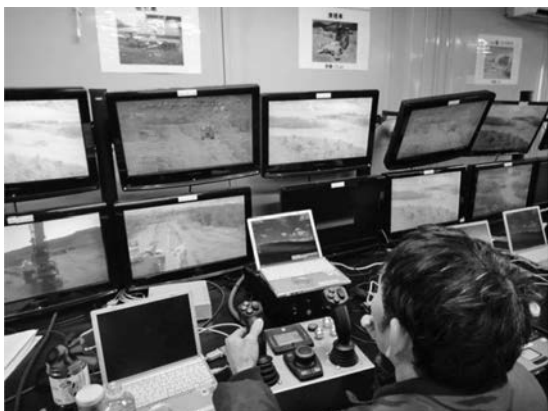
写真—4 無人化施工操作室
