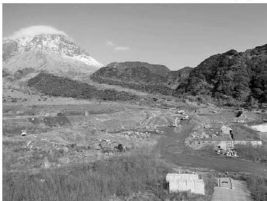
写真一 1 床固工工事施工状況①
