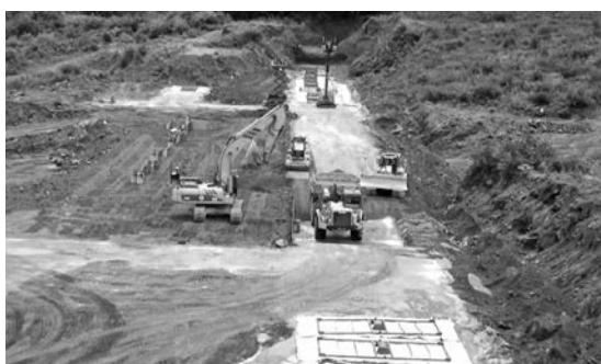
写真一 2 床固工工事施工状況②
