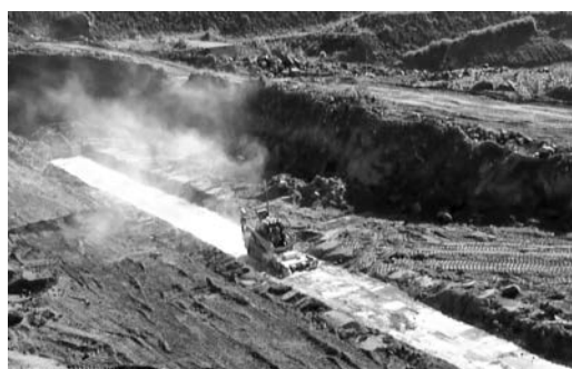
写真—6 清掃作業状況
