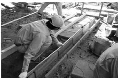
写真一 2 3 年生総合実習（施工実習）
