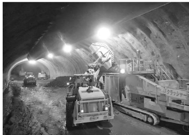
写真—1 急速ズリ処理システム
